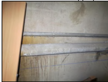
Photo N° 641 AMIANTE CIMENT - CAVE 6_S.sol Conduits de fluide Chute E.U.(Fibres-ciment)
