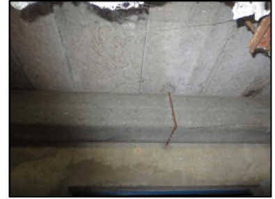
Photo N° 637 AMIANTE CIMENT -- COULOIR CAVE Conduits de fluide Ventilation haute (Fibres-ciment)
