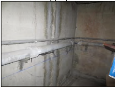
Photo N° 640 AMIANTE CIMENT - CAVE 5_S.sol Conduits de fluide Chute E.U.(Fibres-ciment)
